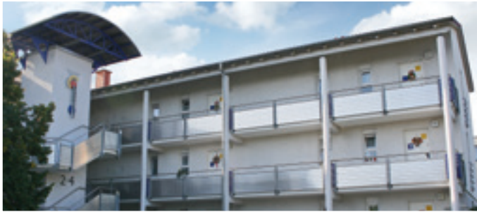
Gemeindliche Seniorenwohnanlage, Dossenheimer Straße
